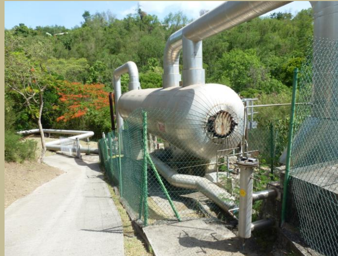
Séparateur haute pression .Bouillante (CFG Services)
