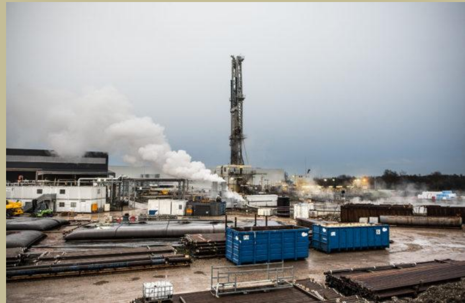
Chantier géothermique de Vendenheim (Alsace)
