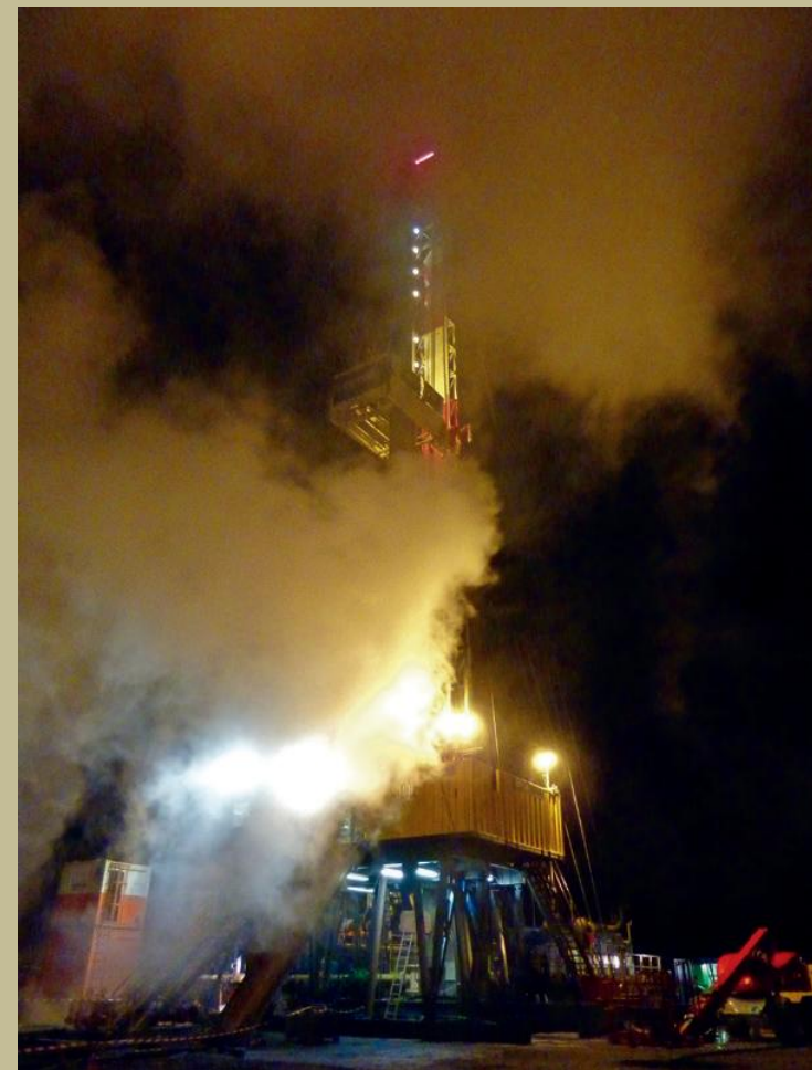
Chantier de forage de Rittershoffen (Alsace)
