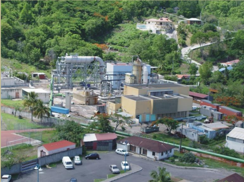
Centrale géothermique de Bouillante (Guadeloupe)
