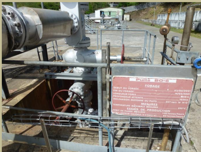
Tête de puits et plateforme de forage. (2008) CFG Services
