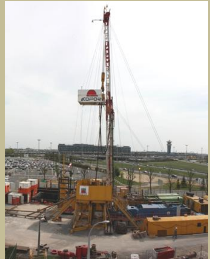
Aéroport de Paris-Orly: chantier en 2010
