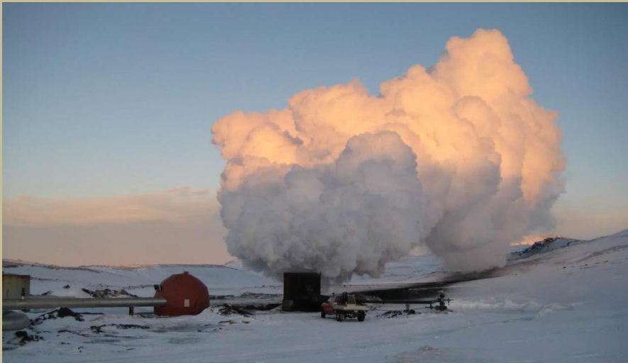
Projet de forage IDDP (Krafla, Islande), pendant lequel on a atteint 400^{\circ} C de vapeur surchauffée à partir de magma en fusion à une profondeur de 2km (photo : Gudni Anderson)
