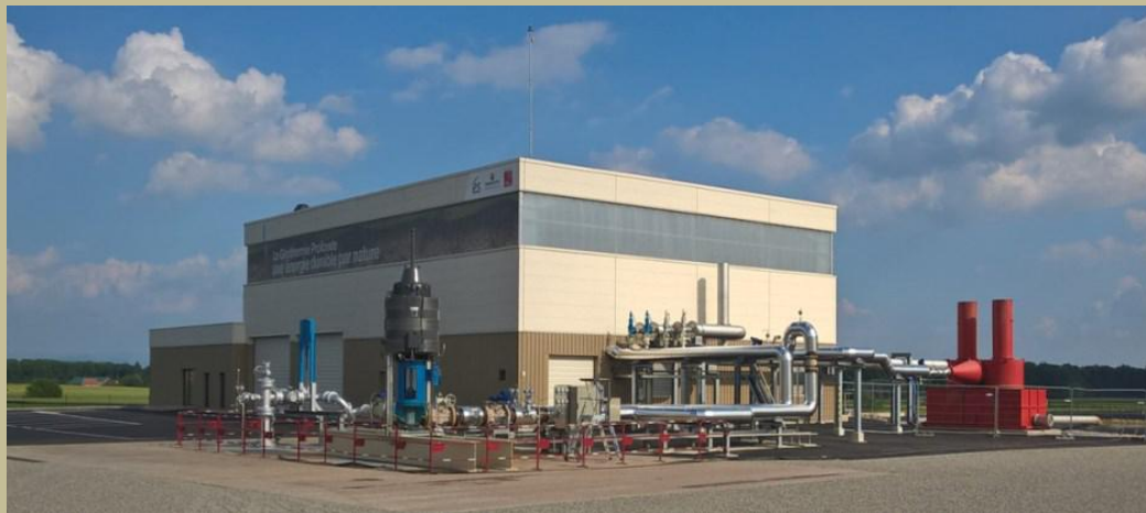
Centrale géothermique de Rittershoffen. Au premier plan, la production (à droite) et le puits de reinjection (à gauche). Le système d'échangeurs de chaleur se situe dans le bâtiment.
