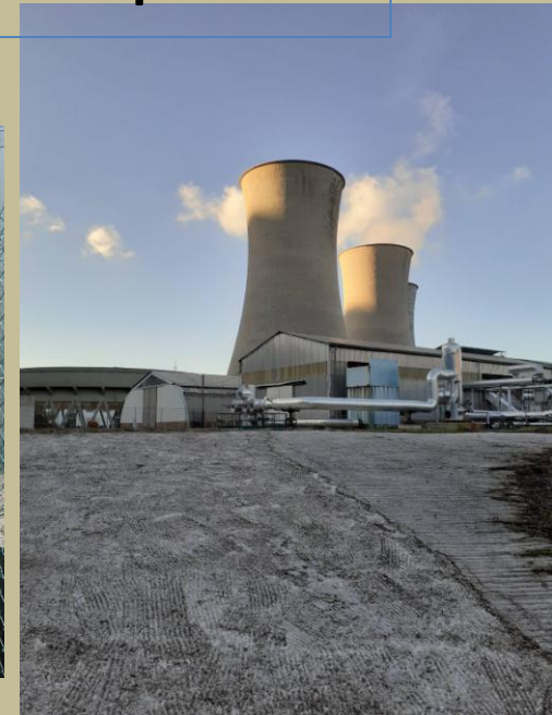
Tours de refroidissement Monteverdi Maritimo, Toscane
