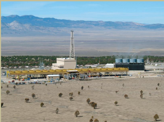
Centrale géothermique Blundell à Roosevelt Hot Springs, Utah, USA (Photo: R. Blackett)
