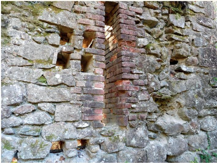
Photo 7 : Murs avec ouvertures permettant le passage des courroies de transmission
