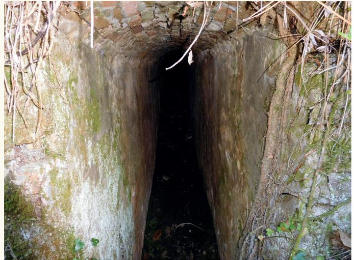
Photo 5 : Conduite d'amenée d'eau à l'usine
