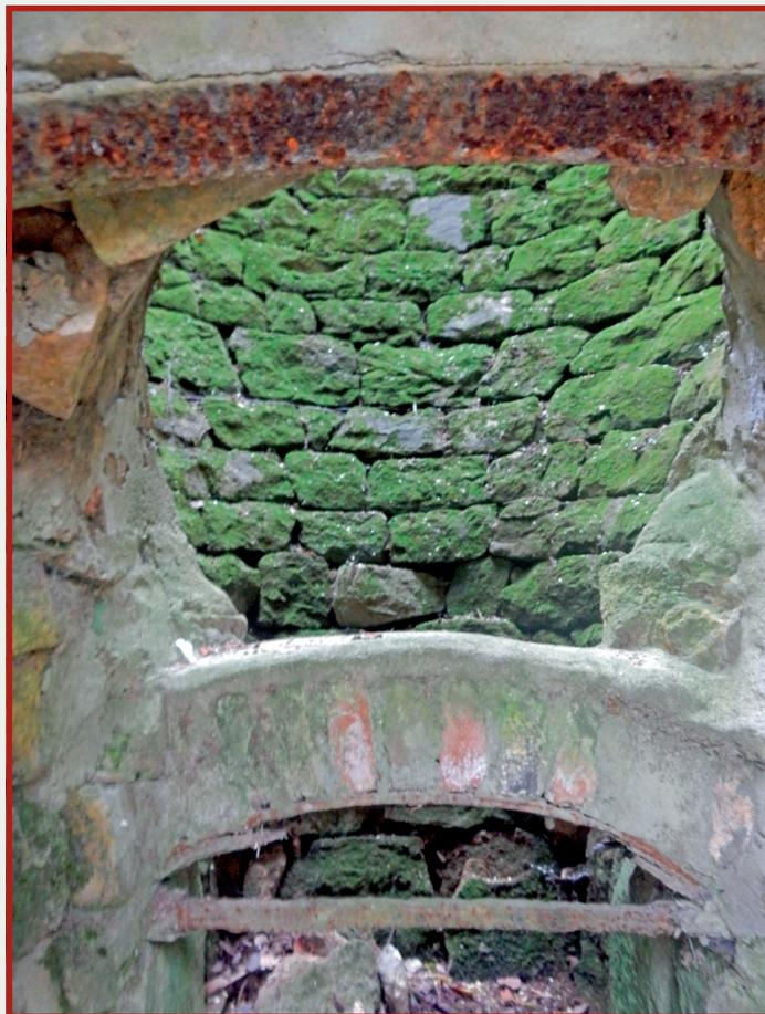
Photo 9 : Structure interne du four à chaux
