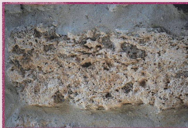
Fig. 4 : Travertin (moellon dans un mur).
