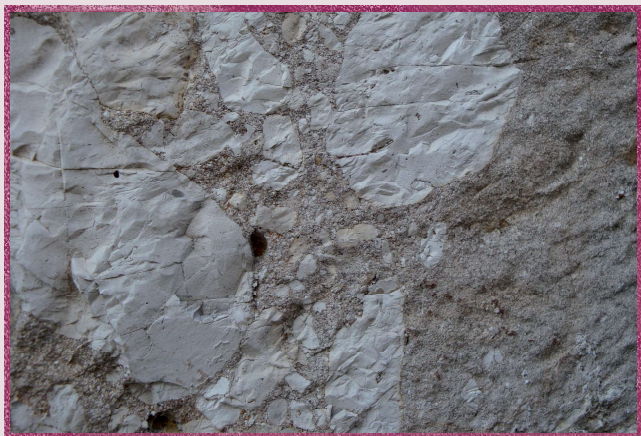
Fig. 2 : Brèche calcaire hétérogène de Chomérac (moellon d'un mur).
