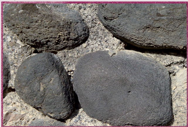
Fig. 5 : Galets de basalte dans un mur.
