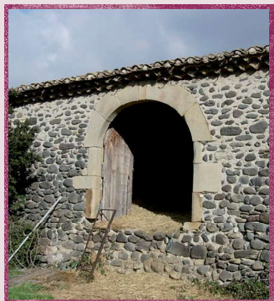
Fig. 12 : Arc d'entrée de grange en grès du Trias.
