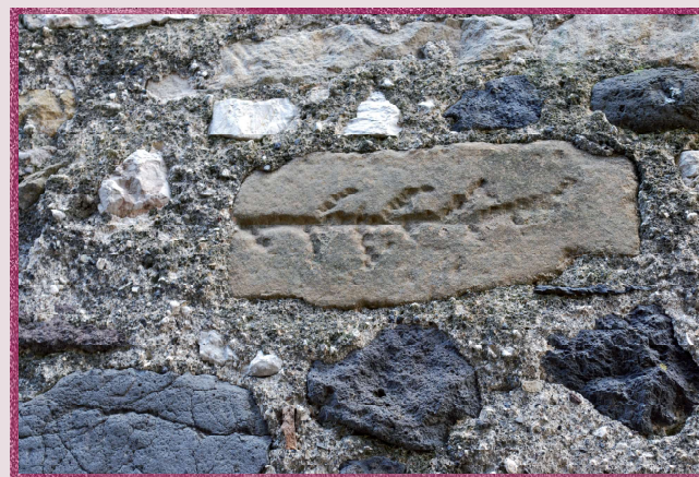
Fig. 10 : Molasse sableuse de Châteauneuf-sur-Isère avec entailles « techniques ».
