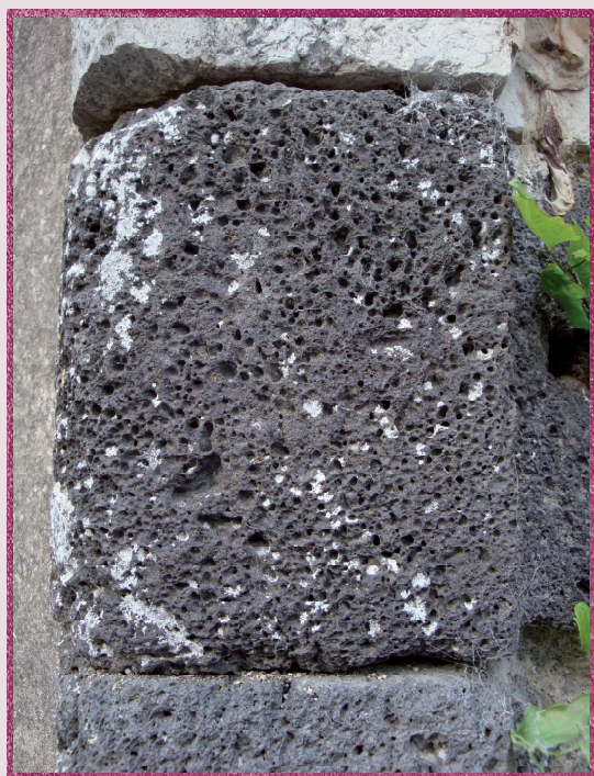
Fig. 6 : Basalte bulleux dans un montant de porte.
