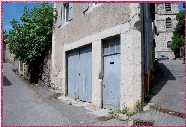
Fig. 13 : Angle de maison avec portes à montants biseautés.
