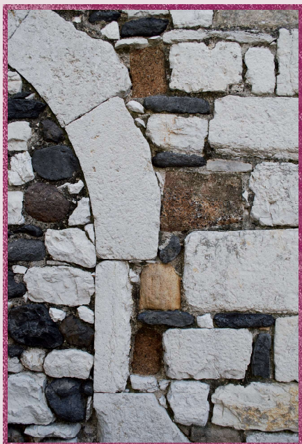
Fig. 11 : Mur hétérogène avec réemploi de grès, brèche volcanique et calcaire de Chomérac taillé.
