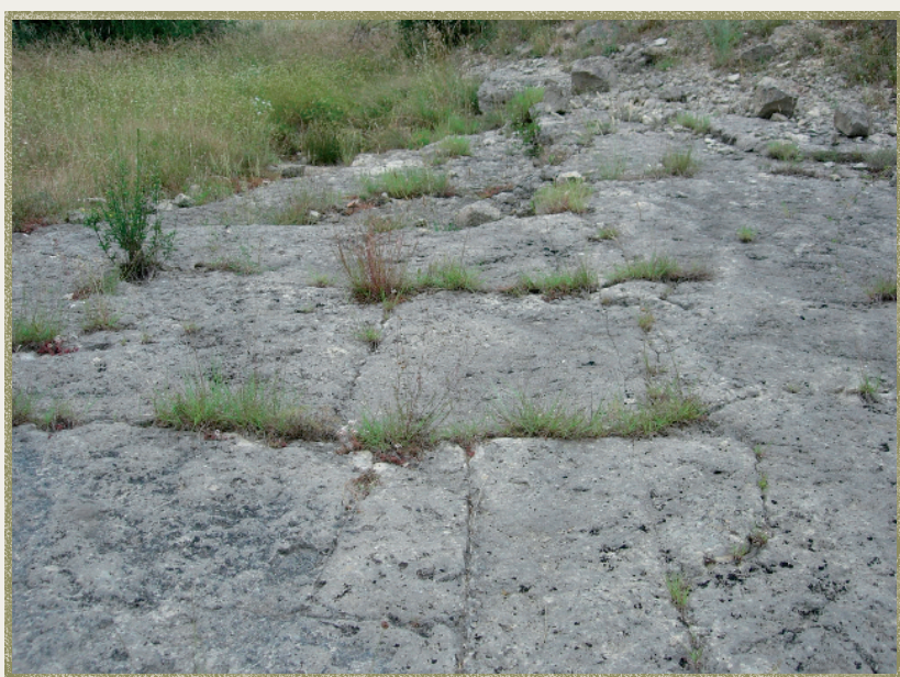
Fig. 9 : Réseau de fractures orthogonales colonisé par de la végétation
