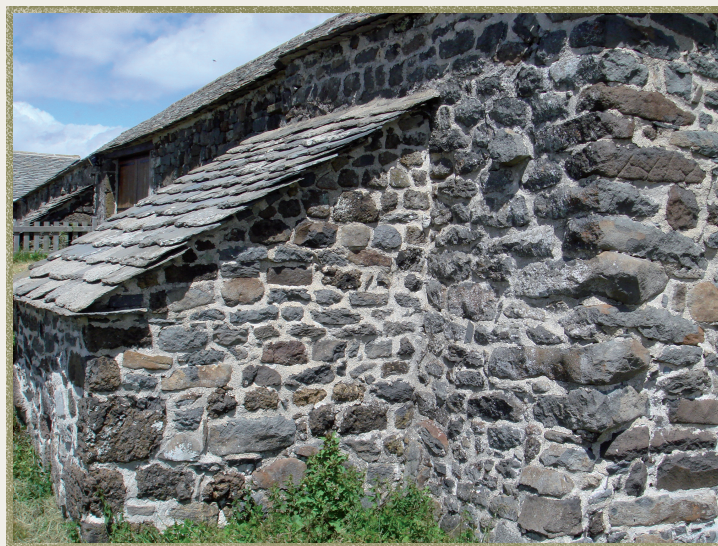
Un mur de grange...
