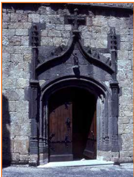
Photo 11 : Porche de l'église de Meyras en vauugnérîte.
