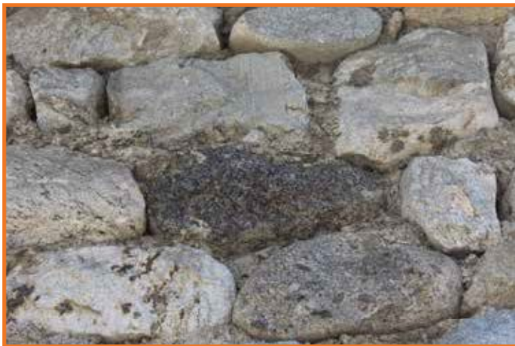
Photo 3 : Un bloc de vaugnérinite dans un mur, rue Jean Moulin.
